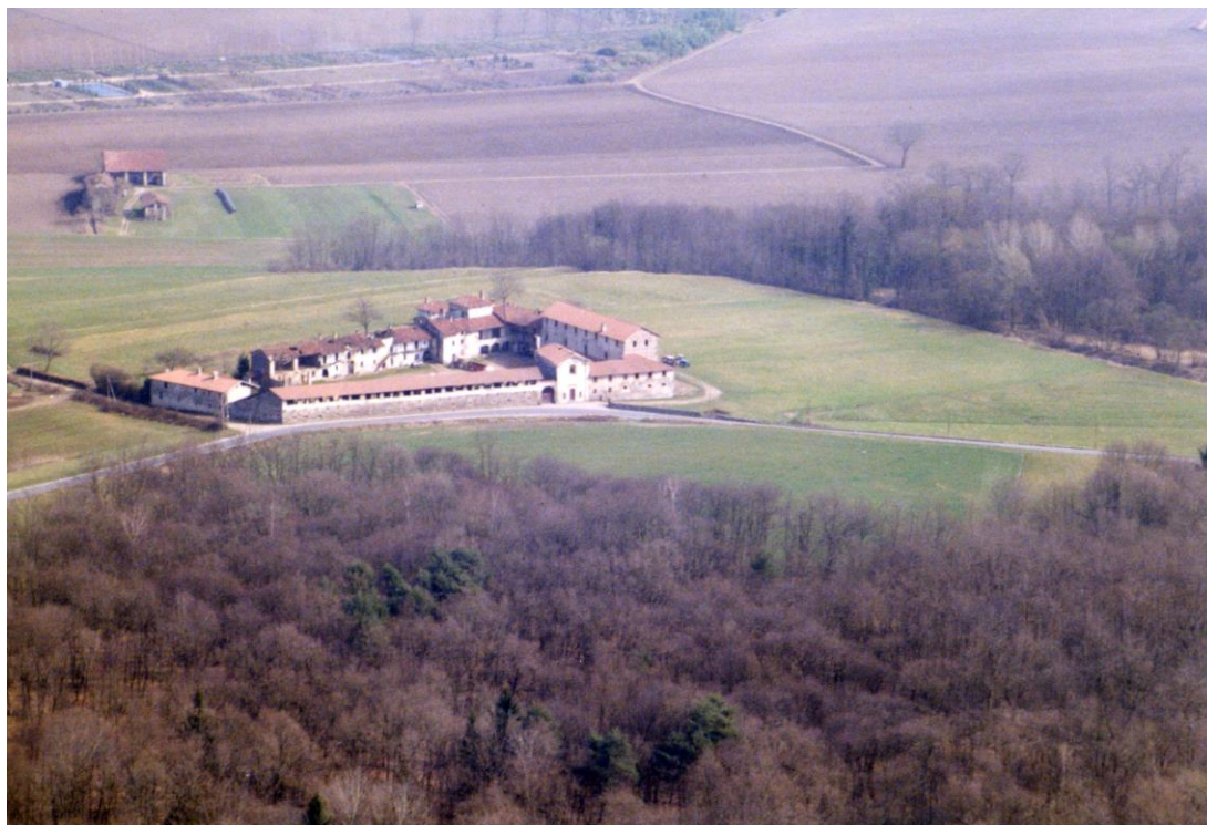
Vista aerea del Muggiano e Mulino
